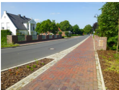
Bild 10: Nebenanlagen Umgestaltung K 257 Ortseingang Langförden; Stadt Vechta
